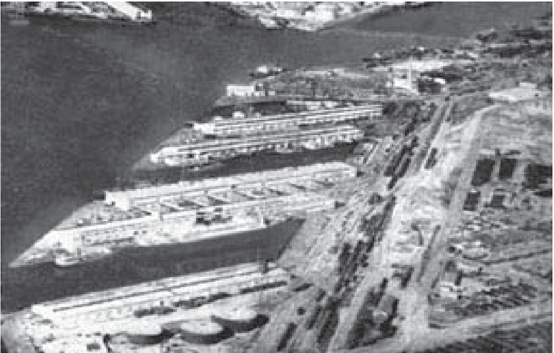
ကမ်းကပ်ဆိပ်၊ ကုန်လှောင်ရုံ၊ စီးရထားလမ်းများဖြင့် စနစ်တကျ တည်ဆောက်ထားသော လော့စိန်းဂျလီမြို့ သင်္ဘောဆိပ်
